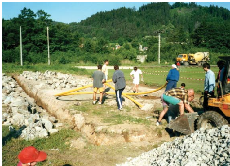
8. 6. 2002 – betonujeme základy Foto: Pavel Vejrosta
